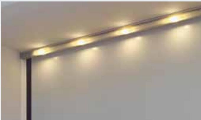
LED-Lichtleiste am Sturz montiert
